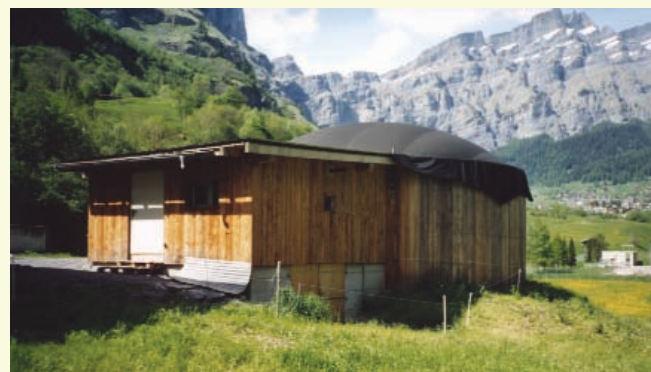
Kompaktbiogasanlage Eugster, Leukerbad: Fermenter, Gasfolie und Technikraum sind zu sehen.
